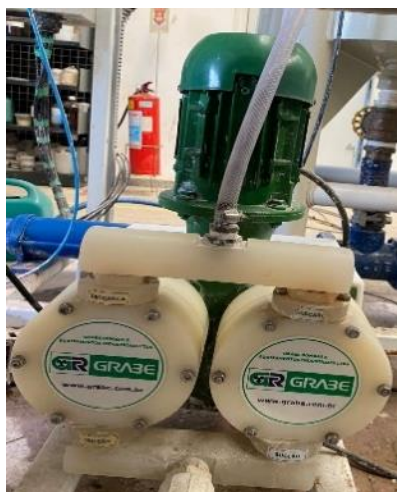
Figura 3.12 Bomba dosadora Grabe. Fonte: Autor, 2024.
