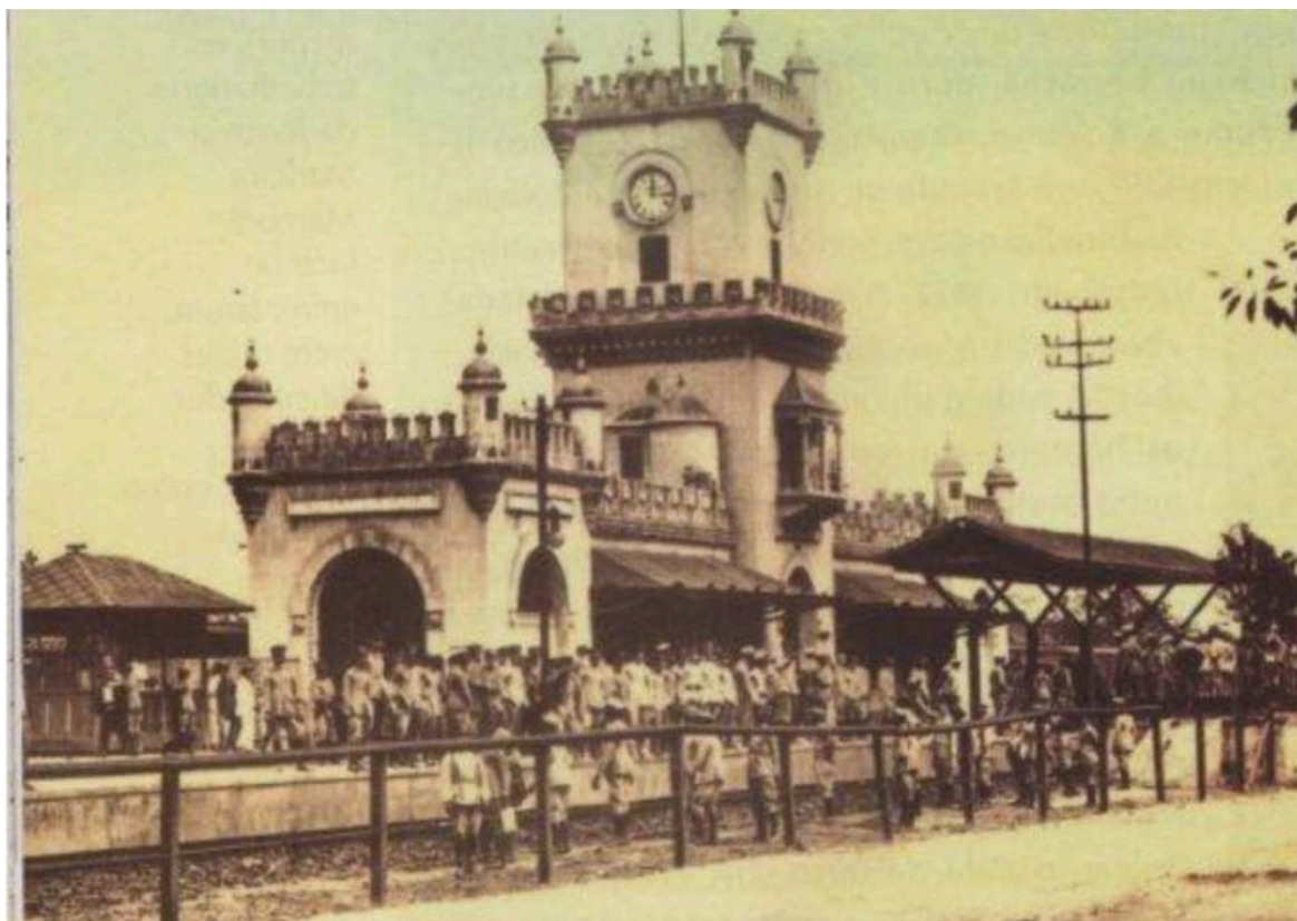
Figura 21: Estação Ferroviária da Vila Militar (1910). Fonte: Arquivo Histórico do Exército.
