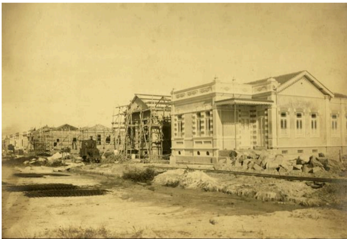
Figura 24 - Construção de Residências para oficiais - Vila Militar 1908 Fonte: Histórico da 1ª Divisão do Exército
