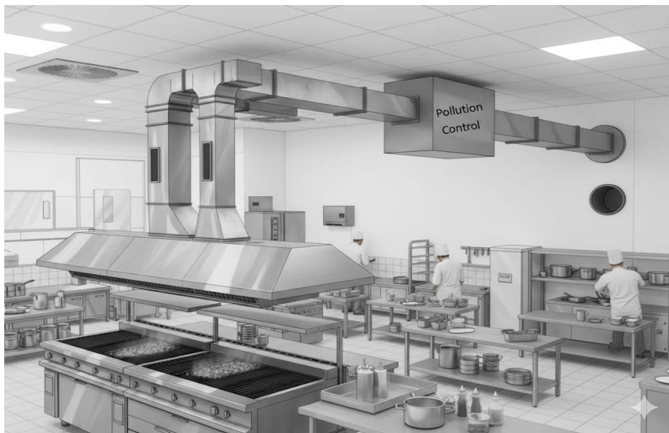
Figura 2 - Sistema de Exaustão de cozinha.
