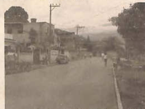
Boa parte da rua já recebeu asfalto
