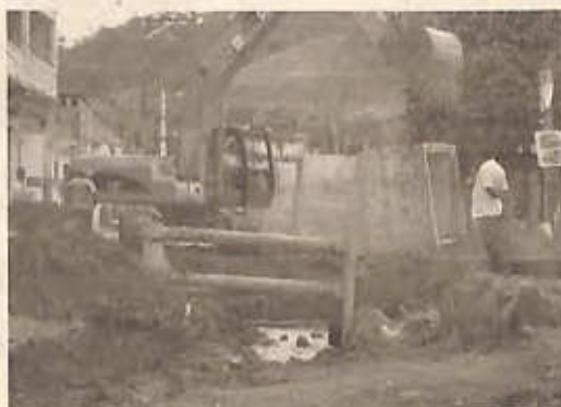
Finalização da canalização do valão
