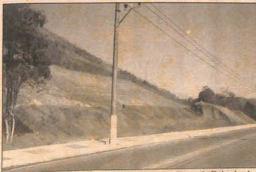
Retirada de barro na entrada da Guarita, Estrada Principal de Xerém
