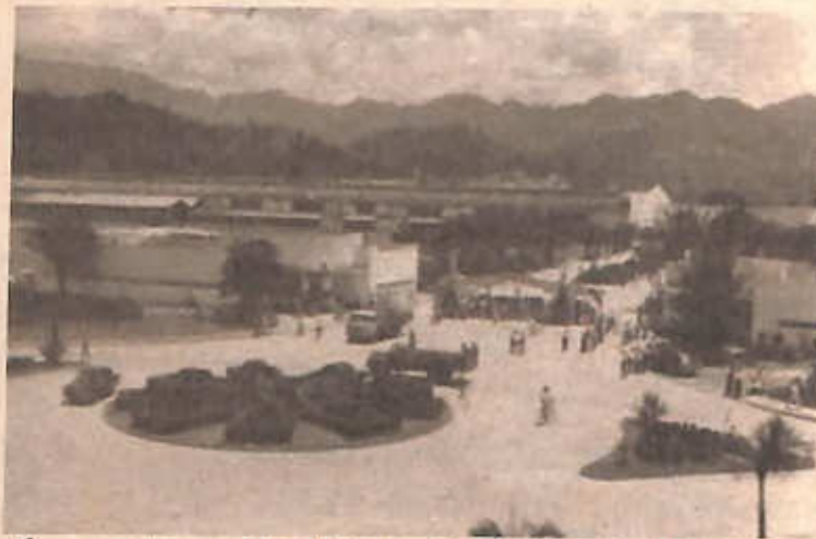
Área externa da Fábrica Nacional de Motores
