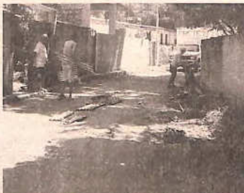
Rua Rio Ramos sofre sem asfalto
