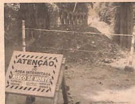
Ponte do Chapéu do Sol: Ainda interditada
