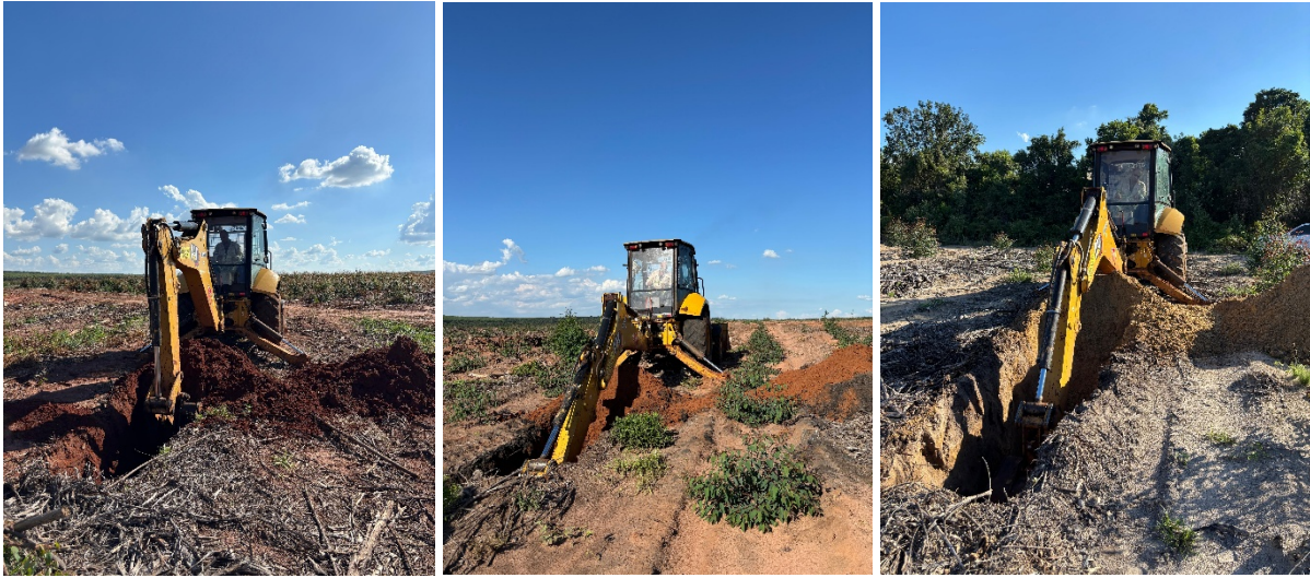
Figura 5 – Abertura das trincheiras para a descrição dos perfis na área de eucalipto. Da esquerda para direita: perfil 1, perfil 3 e perfil 4
