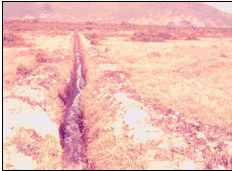
Figura 3 - Fotografia da vala de drenagem da área úmida da restinga, região da Barra da Lagoa.
