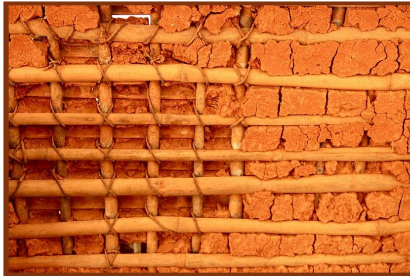
Figura 8 – Taipa de mão, trama de bambus amarrados com cipó, fechamento em argamassa de barro. Esta técnica construtiva vernacular destaca-se pela leveza e adaptabilidade, utilizando materiais locais e renováveis.
