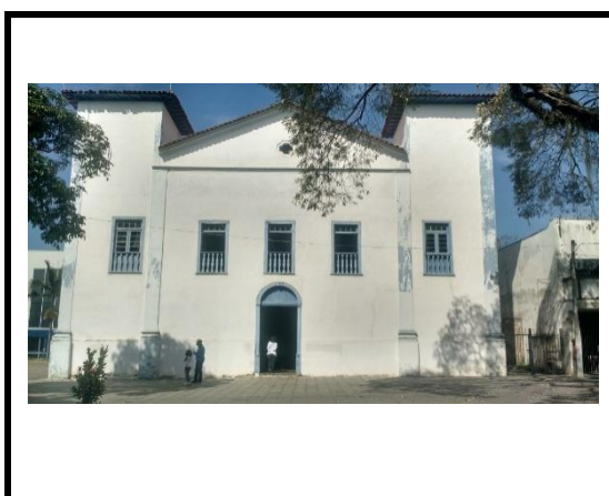
Figura 17 - Igreja São Benedito – Fachada Frontal.
