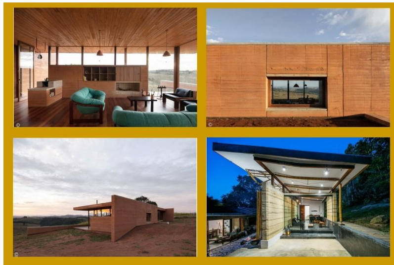
Figura 2 – Casa em Cunha, Vale do Paraíba - SP, Arquipélago Arquitetos. Painéis de taipa compactada evidenciam a excelência do acabamento contemporâneo. A casa está
