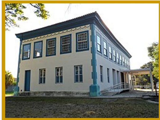
Figura 9 – Solar do Major Novaes em Cruzeiro, São Paulo. Construído em adobe, no pavimento inferior, e pau a pique, no pavimento superior.
