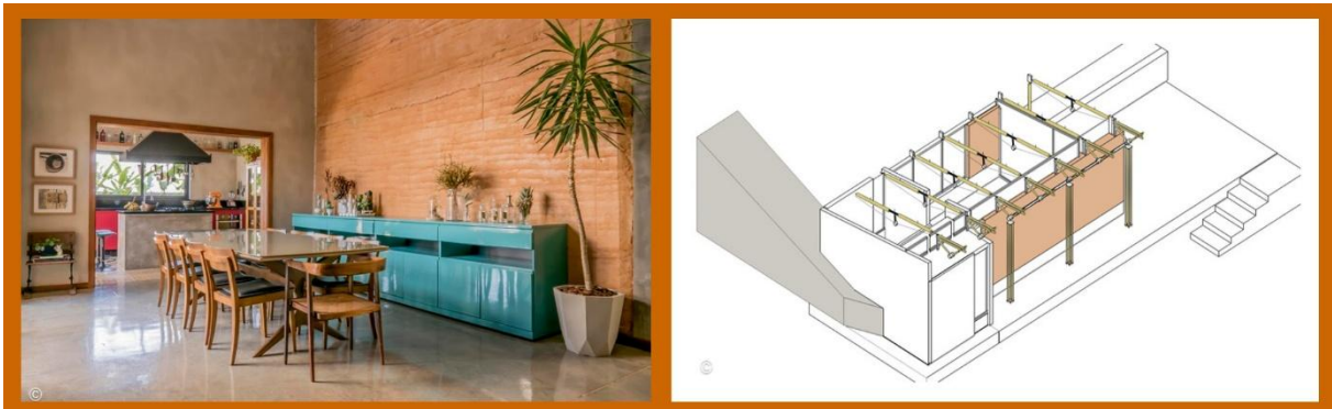
Figura 4 – Casa em Cunha, Vale do Paraíba - SP, Arquipelago Arquitetos. Interior da sala de jantar, a parede em taipa de pilão se destaca no ambiente e se torna protagonista neste cenário. Diagrama mostrando a localização das paredes de taipa de pilão.
