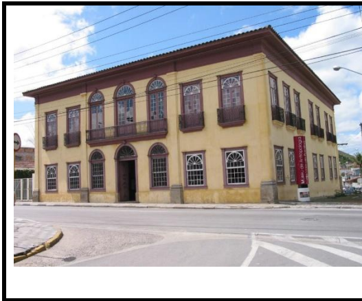
Figura 15 - Solar Gomes Leitão – Fachada Frontal.
