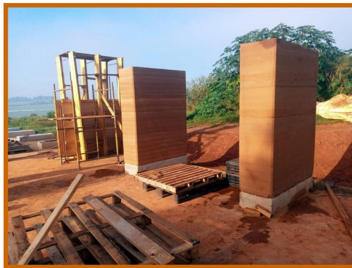
Figura 5 – Aplicação da taipa de pilão em uma edificação contemporânea.
