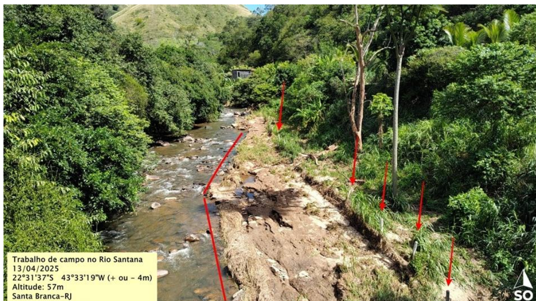
Figura 25: Ponto “c” (bairro Santa Branca-RJ). Intenso assoreamento e formação de um imenso banco de areia
