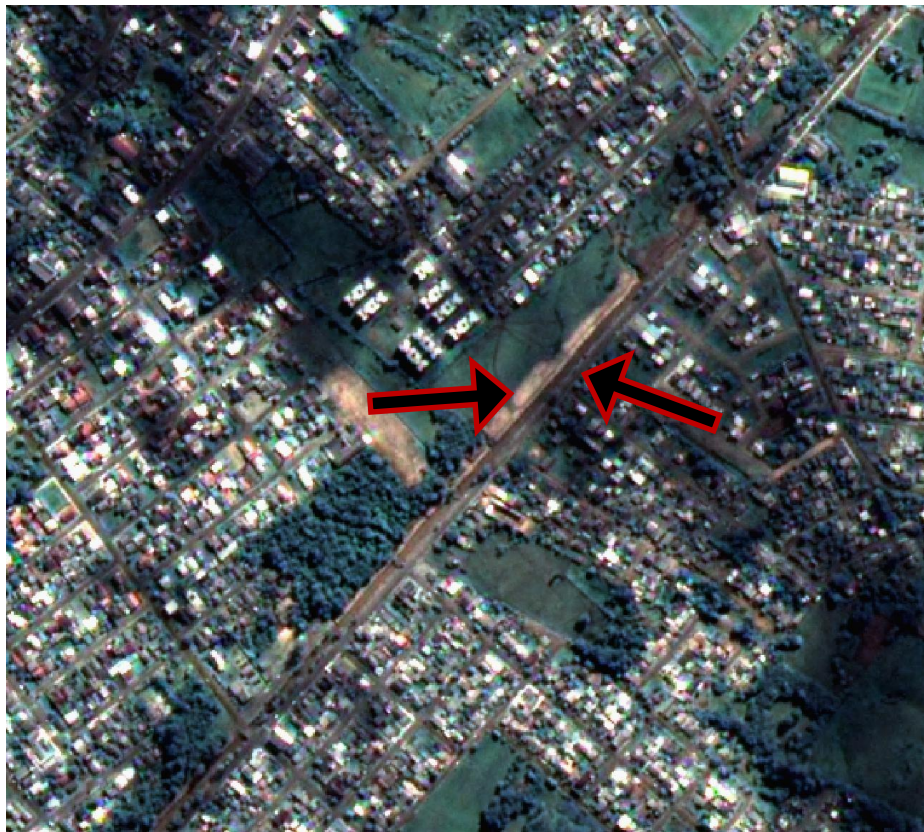
Figura 11 - Imagem de parte da área de interesse após a intervenção realizada (09/05/2024), com visão do curso d'água, solo descoberto, vegetação remanescente, acompanhando a rua Lottar Machado dos Reis.
