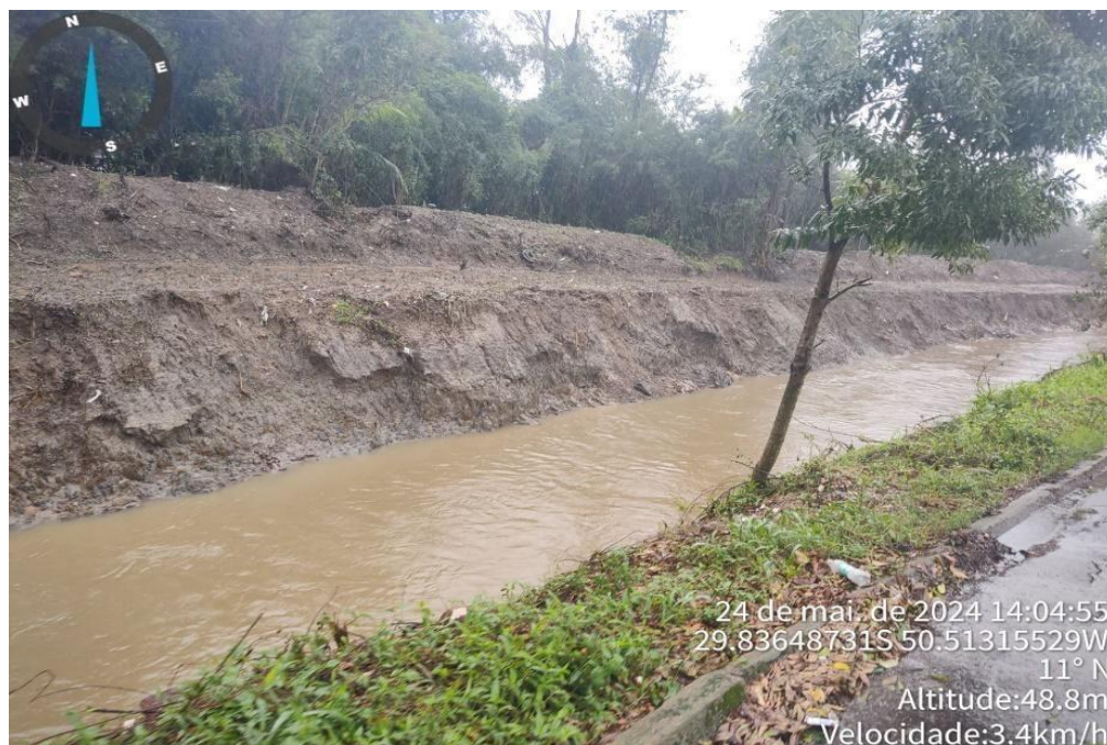
Figura 4 - imagem obtida in loco da área de estudo onde é possível observar o início do processo de erosão. Localizada na rua Lottar Machado dos Reis, nas margens do arroio Passo dos Ramos em Santo Antônio da Patrulha (RS). Foto de 2024.
