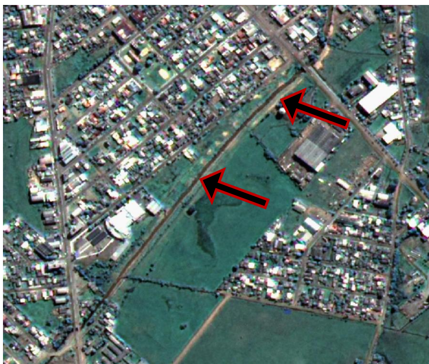
Figura 13 - imagem de parte da área de interesse após a intervenção realizada (09/05/2024), próximo ao limite urbanizado da cidade
