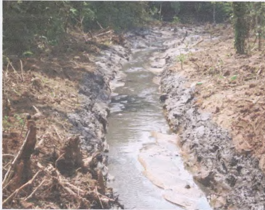
FOTO 8 – Detalhe mostrando o chorume vazado da CTR de Nova Iguaçu (a partir possivelmente do transbordamento das lagoas de tratamento de chorume) para o riacho localizado externamente à referida CTR.
