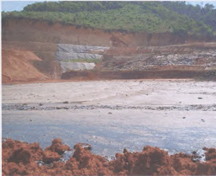
FOTO 6 - Detalhe mostrando a lavagem do chorume na área interna da CTR (Central de Tratamento de Resíduos) de Nova Iguaçu, com as recentes chuvas ocorridas em outubro de 2009.
