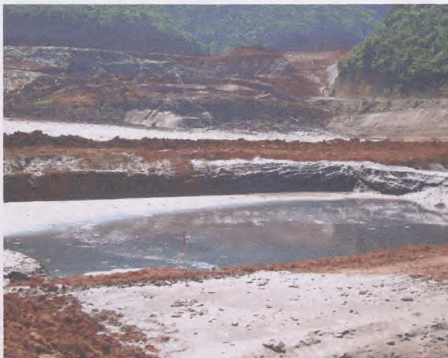
FOTO 7 - Detalhe mostrando o chorume vazado das lagoas de tratamento de chorume na CTR de Nova Iguaçu, com as recentes chuvas ocorridas em outubro/2009.
