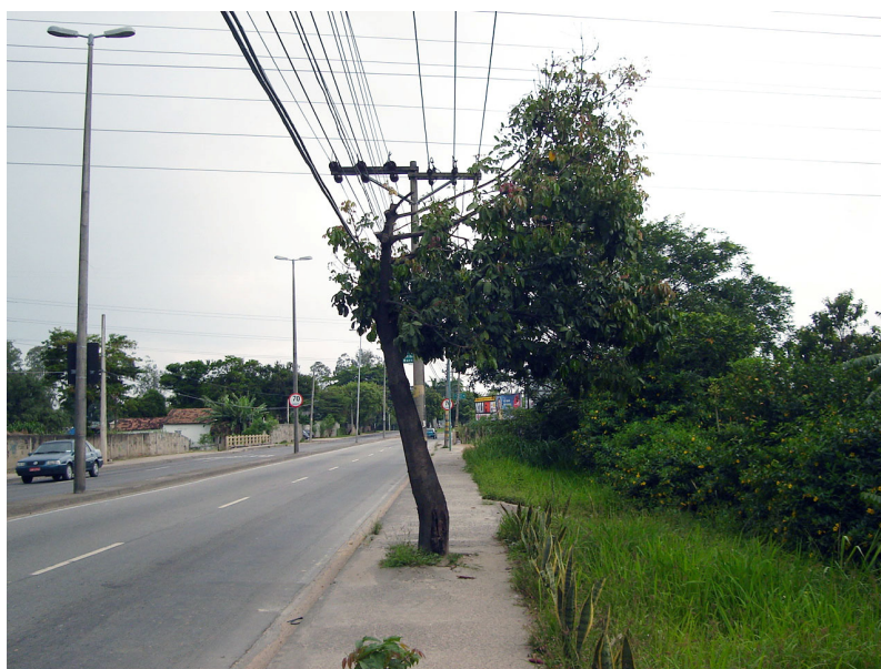
Figura 2. Copa desbalanceada de Pachira aquatica (munguba) após poda severa uma vez em conflito com a fiação.
