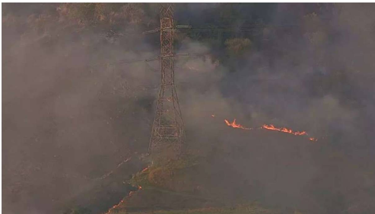
Figura 8. Incêndio no PEPB, localizado no bairro de Realengo.
