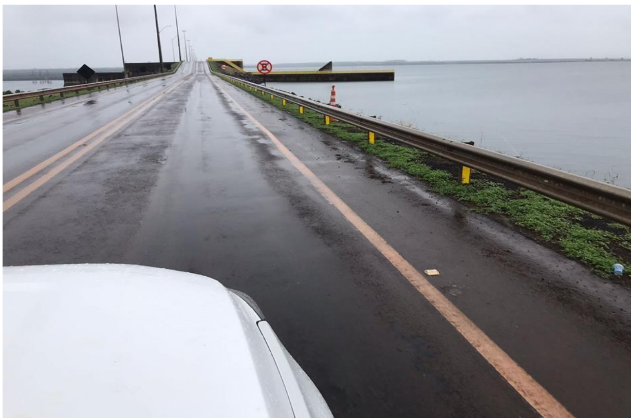
Figura 21 — Barragem da Usina Hidroelétrica na Cidade de Ilha Solteira Fonte: O autor (2025).
