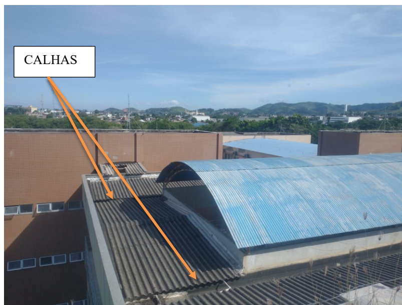
Figura 30 - Telhado sobre a passarela - com calha
