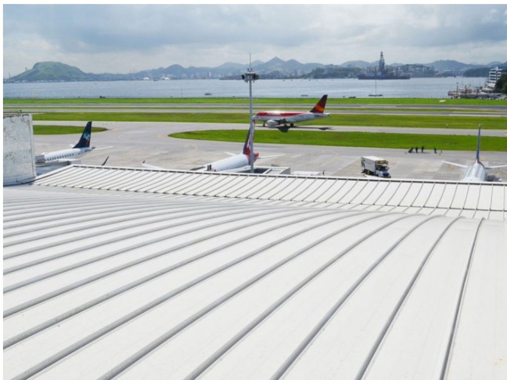
Figura 22 - Telhado do Aeroporto Santos Dumond
