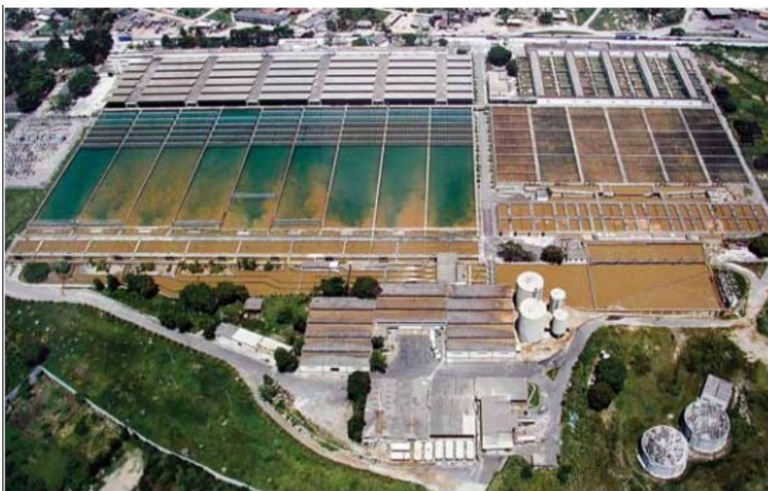
Figura 16 - Maior Estação de Tratamento de água do Mundo - CEDAE-RJ
