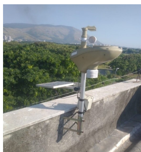
(b) Detalhe da instalação sobre a mureta técnica
