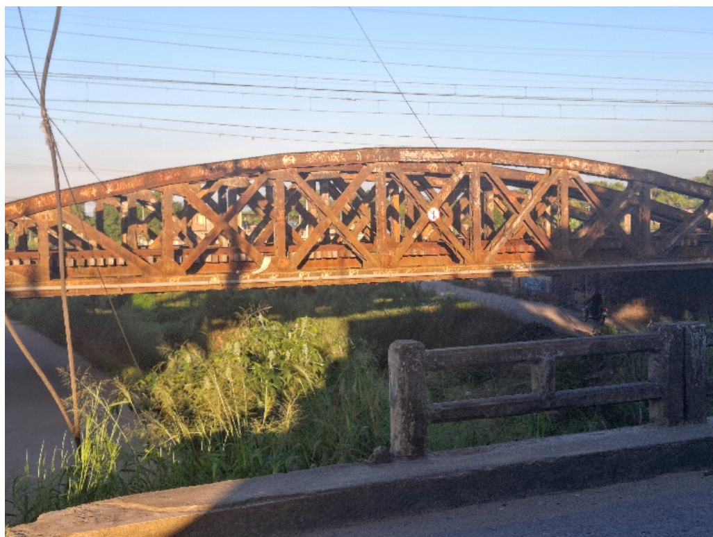
Figura 1: Ponte de Ferro próximo à estação de Engenheiro Pedreira.
