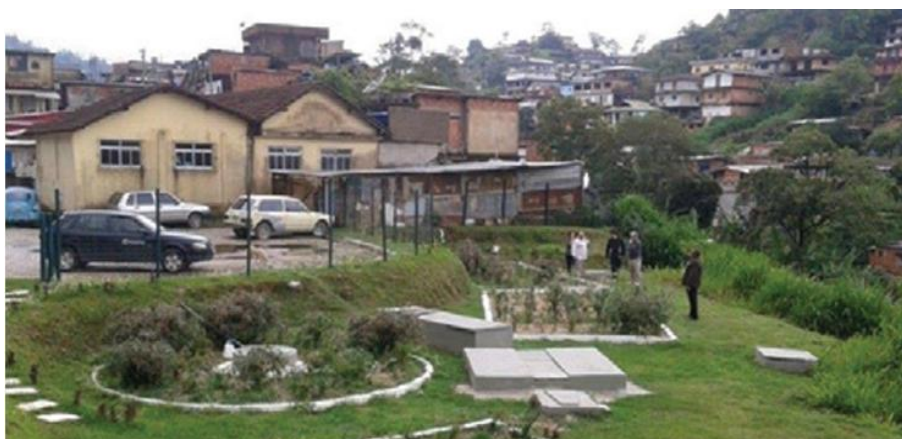
Figura 22 - SbN para tratar águas residuais: residuais: biodigestor e várzea construída em Vila Ipanema, Petrópolis - RJ. Fonte: HERZOG E ROSADO (2019).
