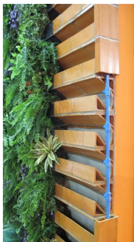
Figura 52 - Jardim vertical com métodos construtivos incorporados no muro. Fonte: PAISAGISMO EM FOCO (2017) 29 .
