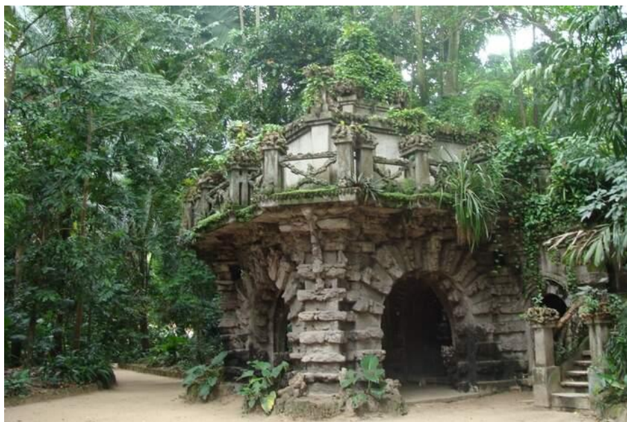
Figura 3: Foto da “monumental caixa d’água” do Museu Paraense Emílio Goeldi em Belém.
