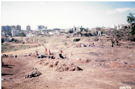
Figura 5: Etapa de limpeza da área para a construção do parque. Ano: 1997. Fonte: Acervo da Prefeitura de Vitória (Cód. 19733).
