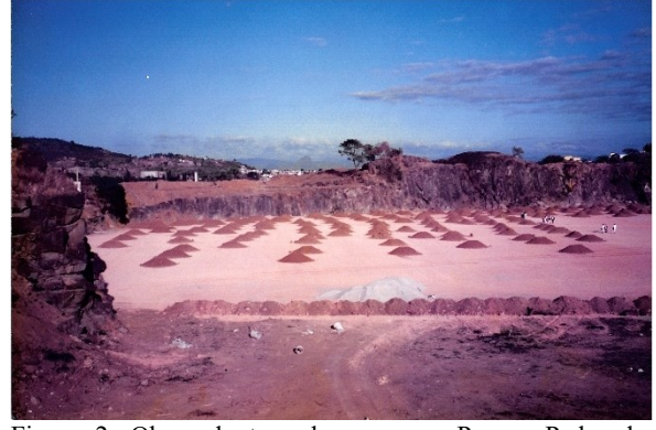
Figura 2: Obras de terraplanagem no Parque Pedra da Cebola, em Vitória/ES. Ano: 1997. Fonte: Acervo da Prefeitura de Vitória (Cód. 19730).
