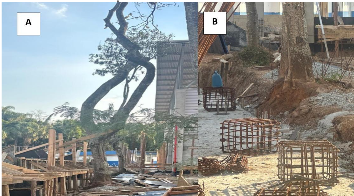
Figura 11 -Construções de edificações próximas as árvores da espécie de espatodea e leucena na obra 2.
