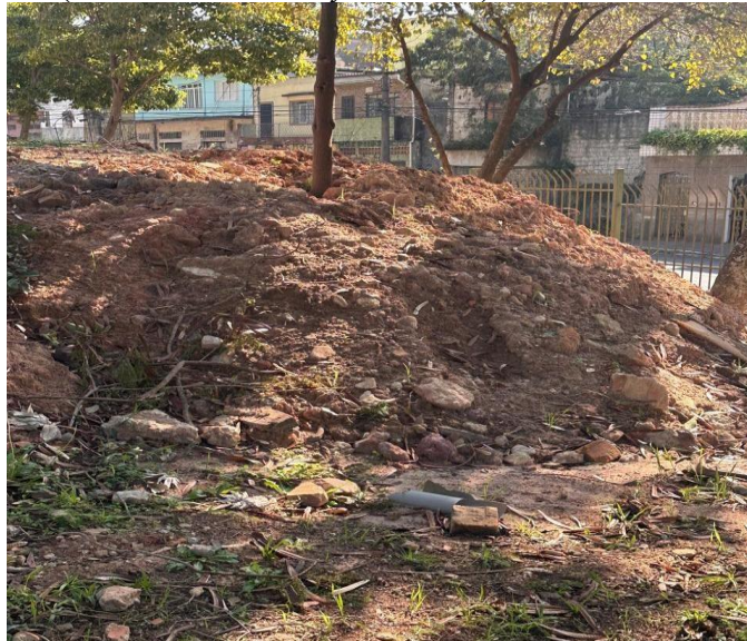
Figura 15 - Soterramento de raízes de amoreira e três ipês amarelos ( Handroanthus chrysotrichus ) na obra 1.
