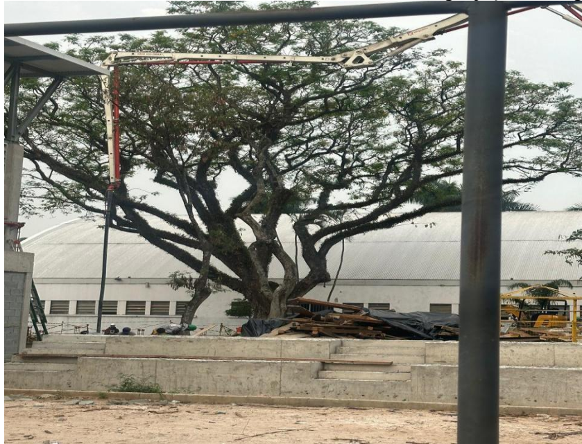
Figura 8 - Bomba de concreto com braço articulado na projeção da copa.
