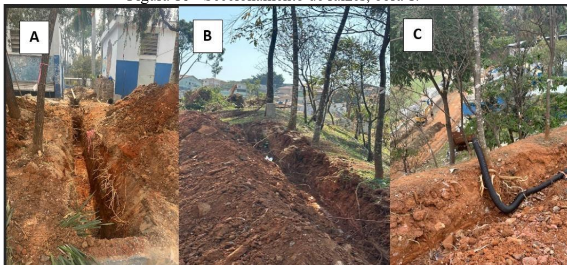
Figura 10 - Seccionamento de raízes, obra 1.
