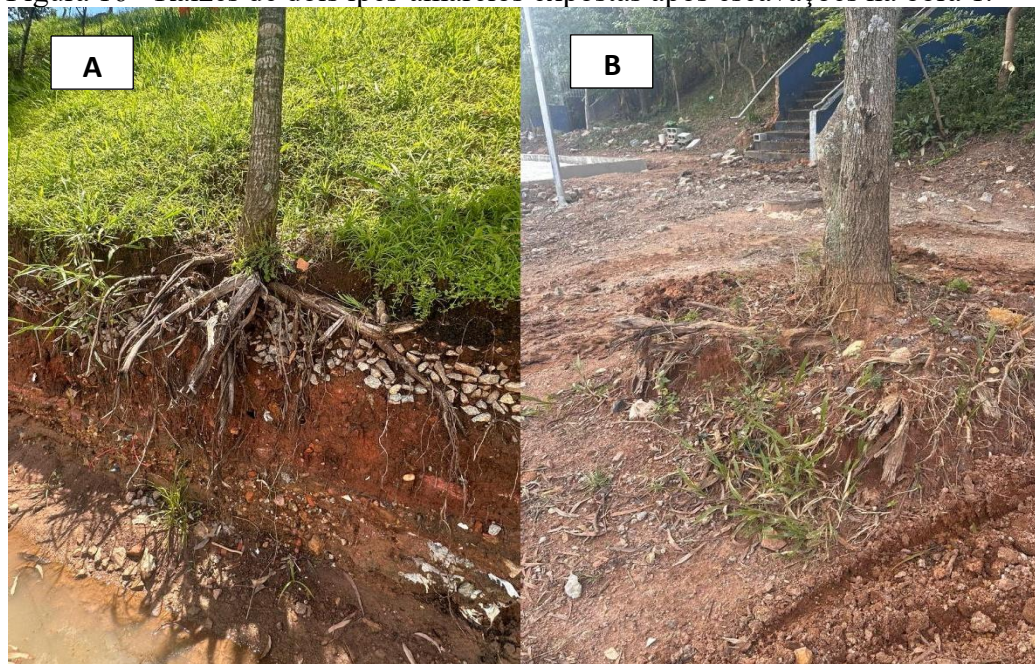
Figura 16 - Raízes de dois ipês-amarelos expostas após escavações na obra 1.
