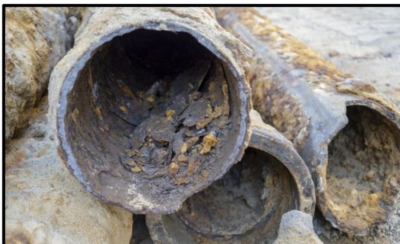
Figura 12 - Dutos de Petróleo expostos a compostos sulfurados, ilustrando a corrosão química.
