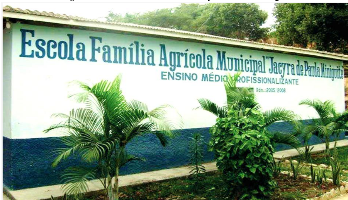
Figura 4 – Fachada lateral da EFA Jacyra de Paula Miniguite
