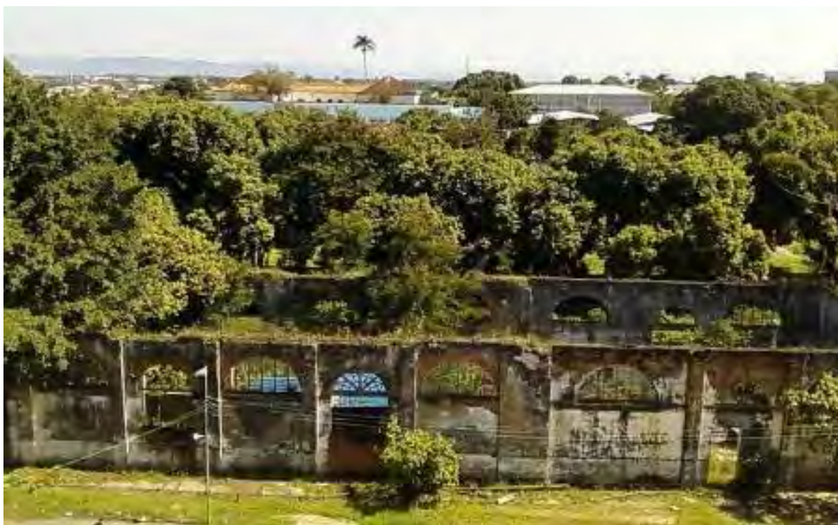
Figura 11: Ruínas do antigo prédio do Matadouro de Santa Cruz
