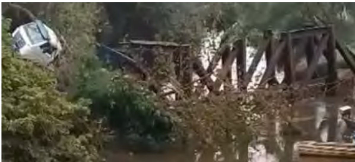
Figura 1: Ponte da linha ferroviária em Santa Cruz
