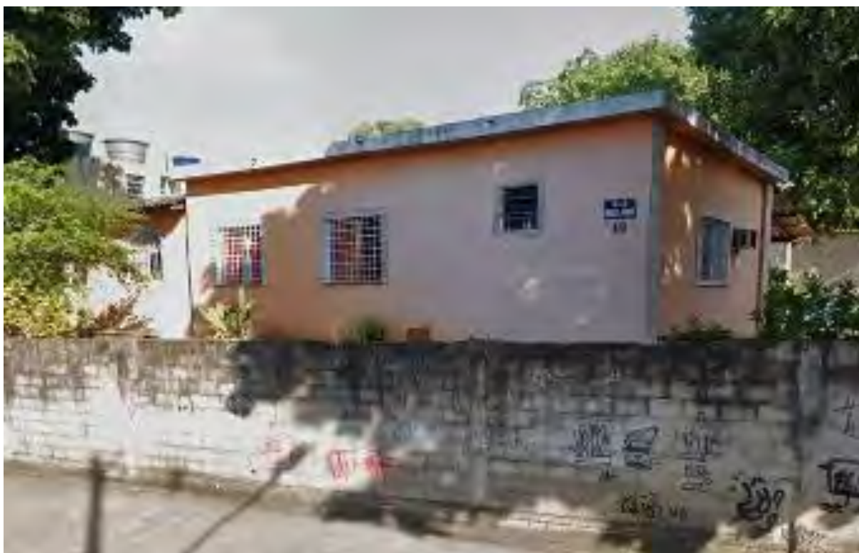
Figura 47: Imóvel situado na Rua Marquês de Maricá, 33. Registro de 2023
