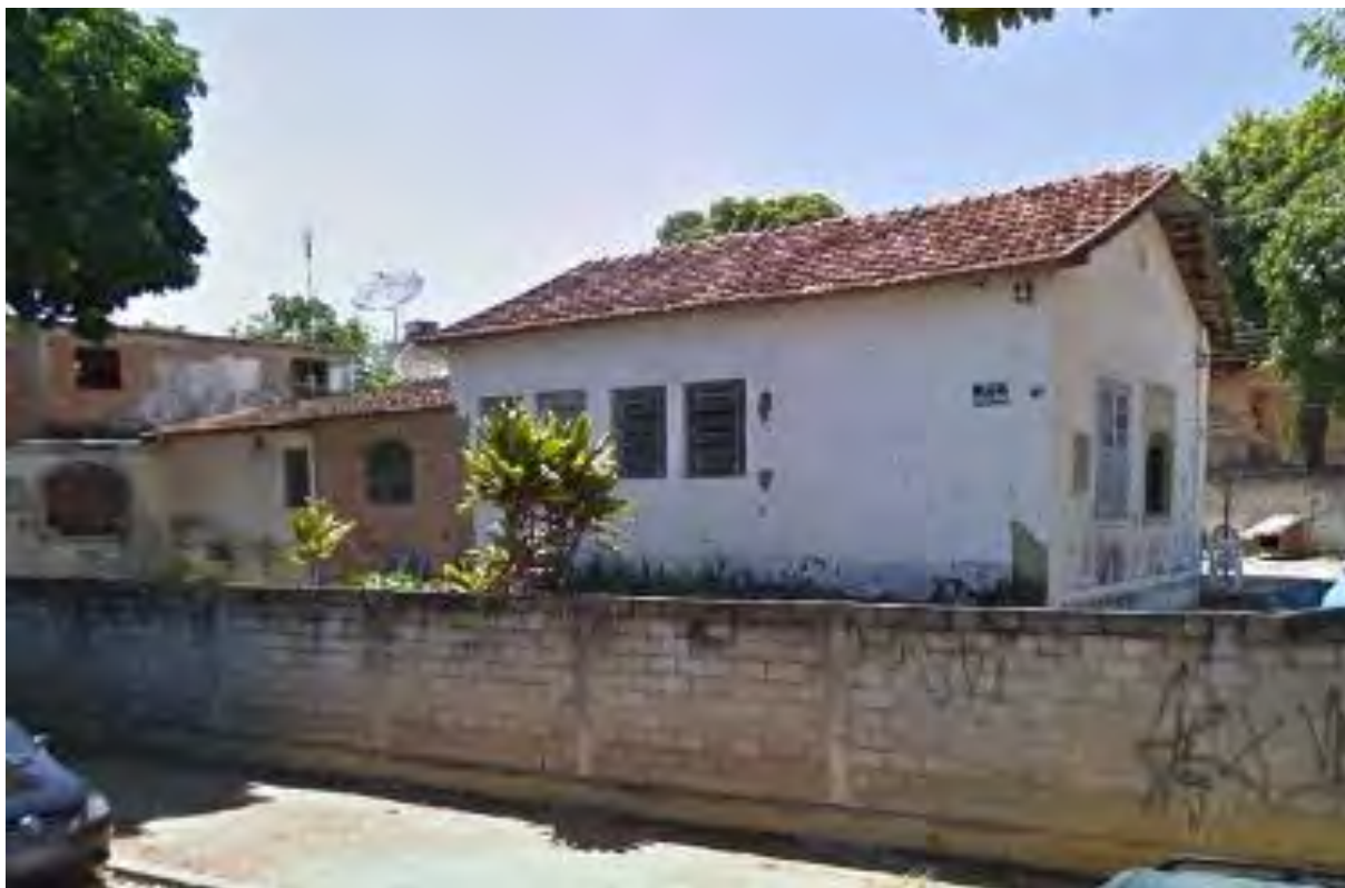
Figura 46: Imóvel situado na Rua Marquês de Maricá, 33. Registro de 2010
