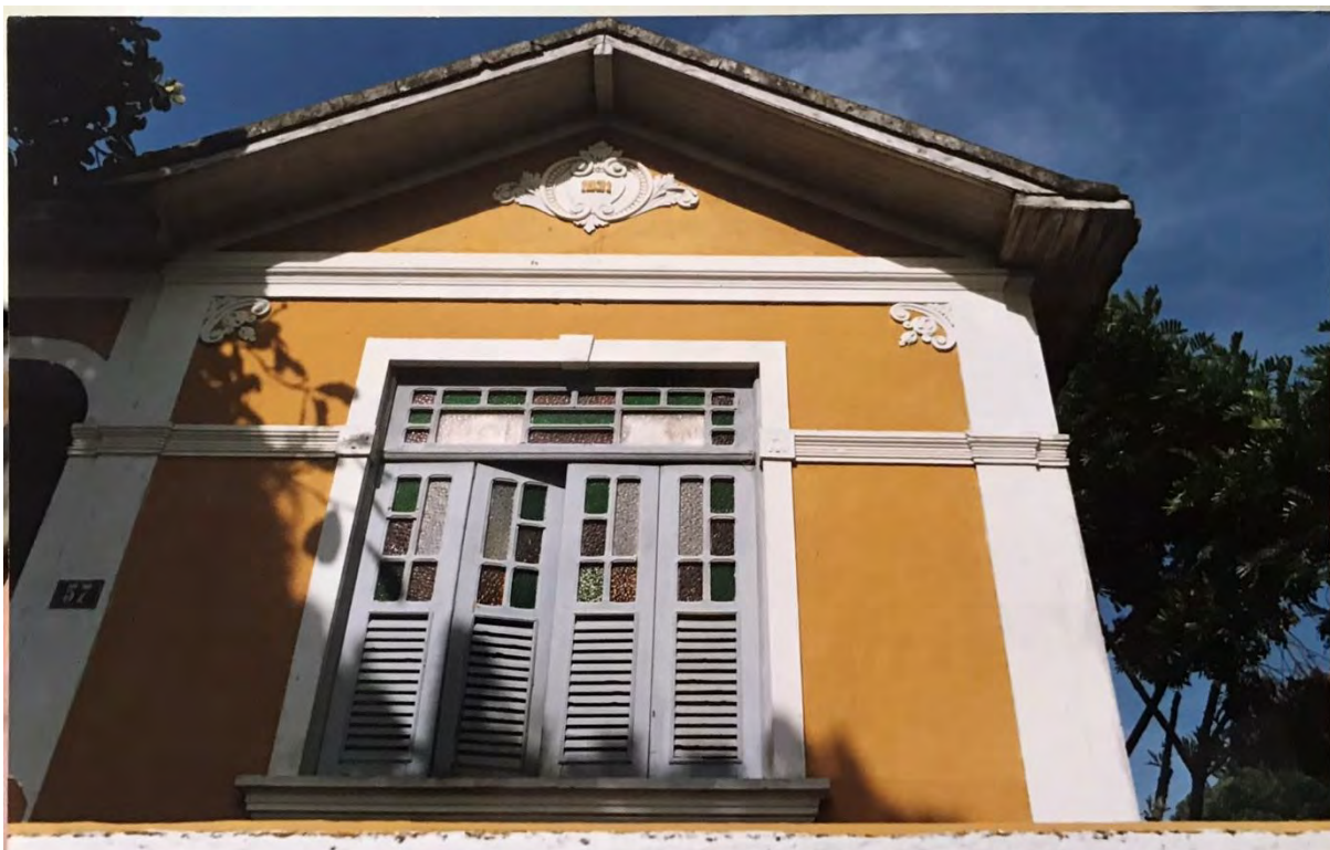
Figura 103: Fotografia da fachada do imóvel
