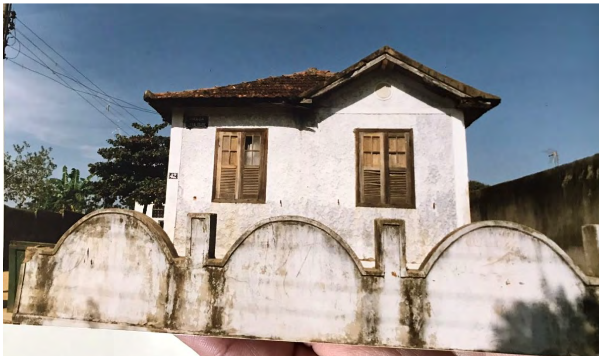
Figura 84: Fotografia da fachada do imóvel
