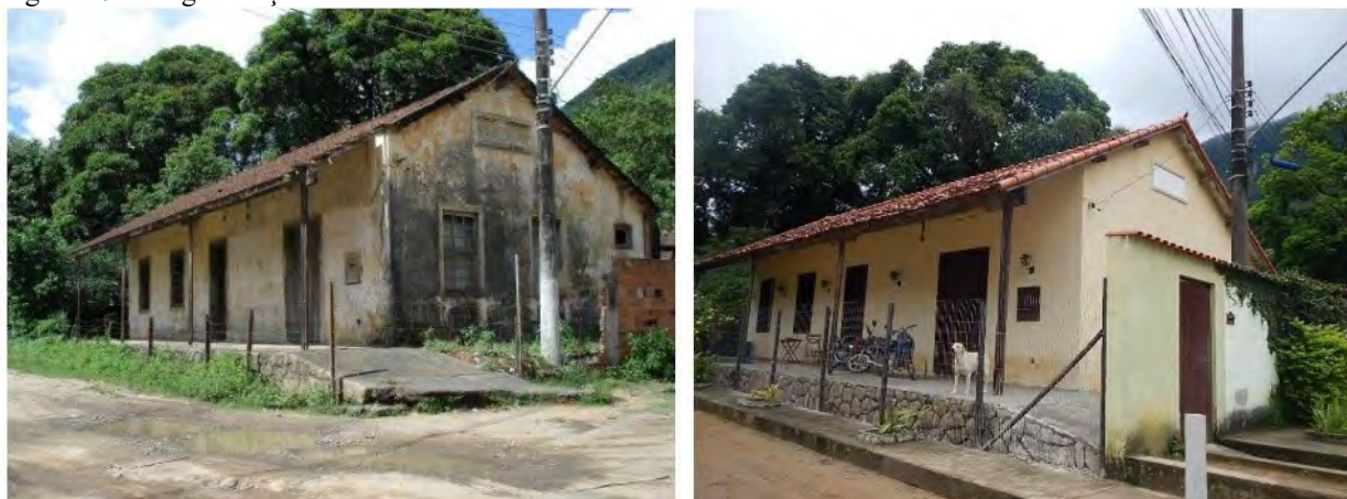
Figura 17: Antiga Estação Ferroviária de Jaceruba.
