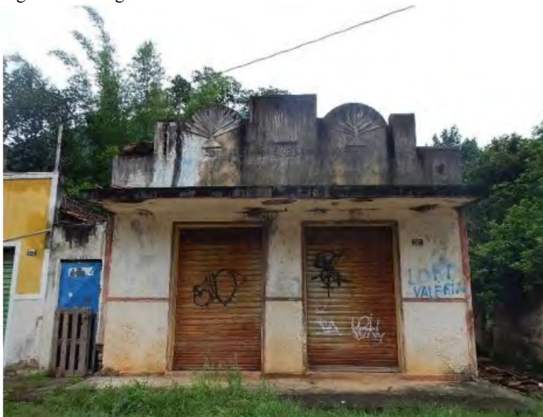
Figura 18: Antigo Armazém São Pedro.
