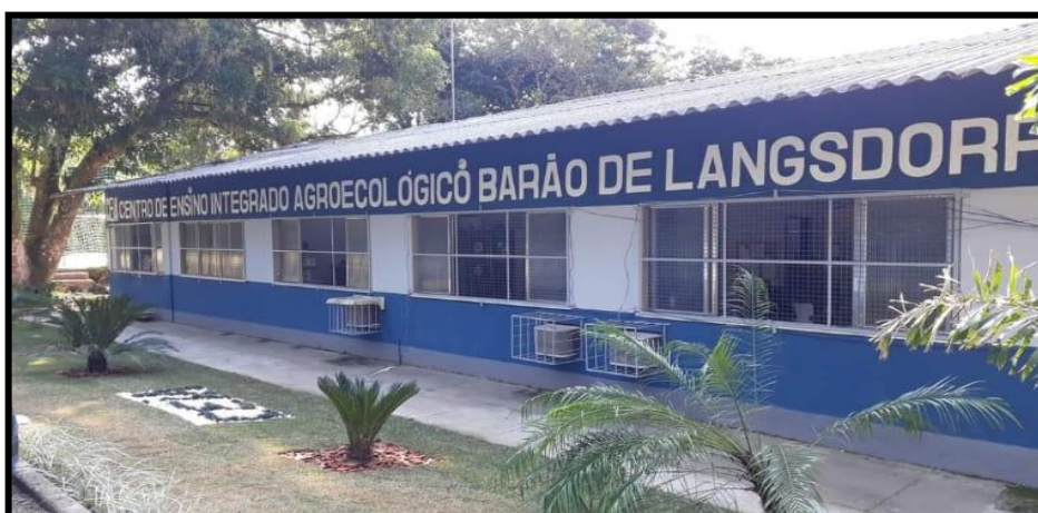
Figura 1 – Fachada do pavilhão 1 do CEIA-BL
