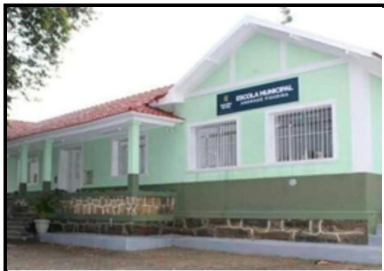
Figura 6 - Fachada da escola
