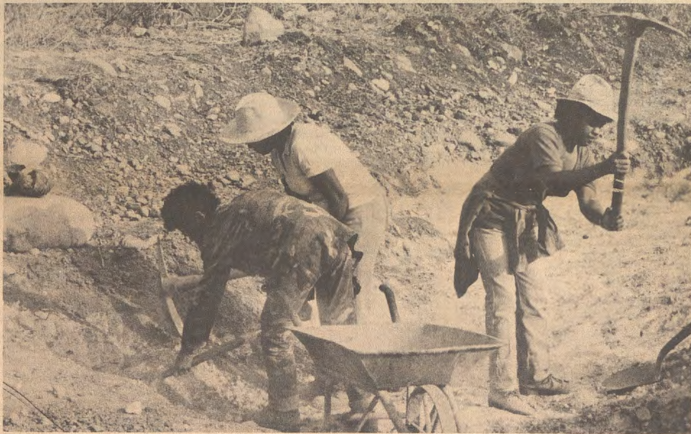
Equipe feminina trabalha na construção da escola
