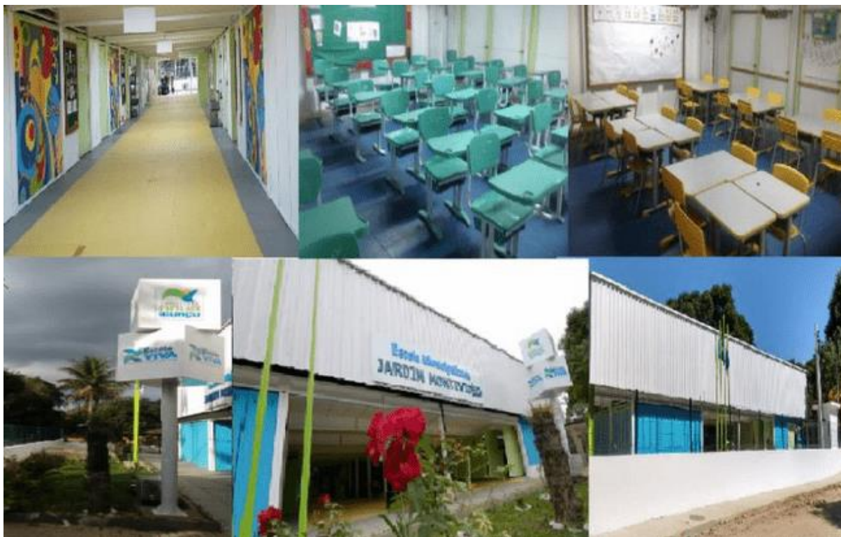
Figura nº 18 – Conclusão das obras de reinauguração da E. M. Jardim Montevideo (2016)
