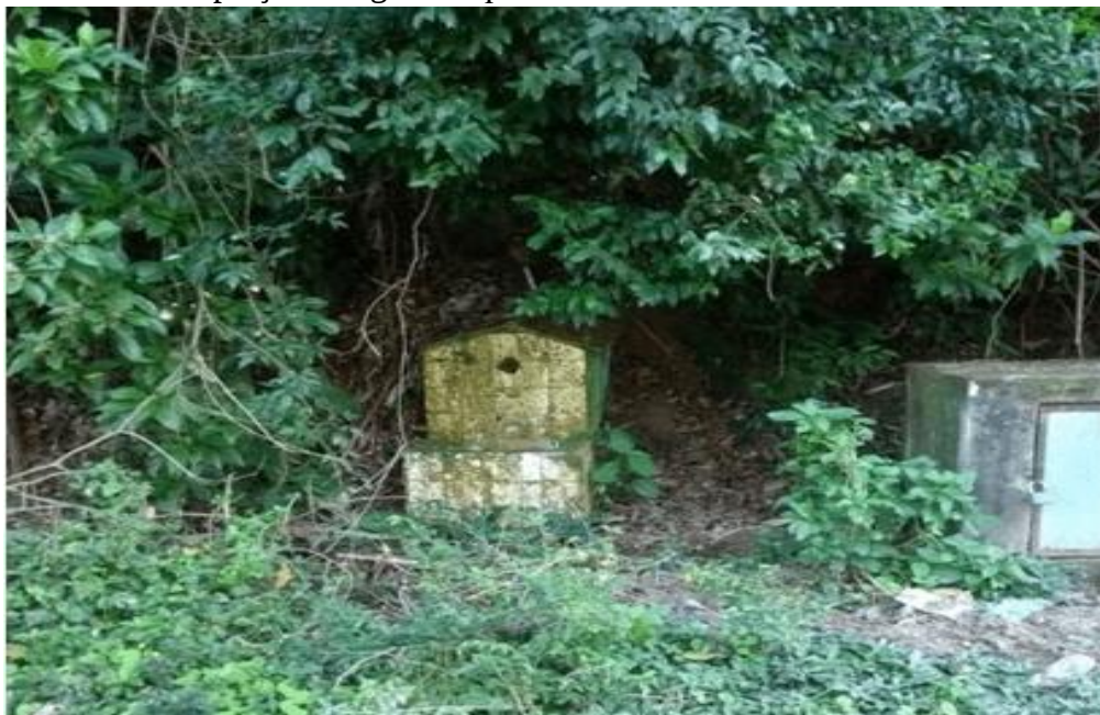
Figura 12. Fonte de captação de água “Biquinha”
