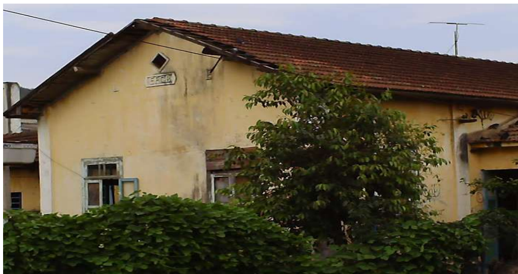
Figura 11: Imagem da antiga Casa de turma da estação ferroviária de Austin
