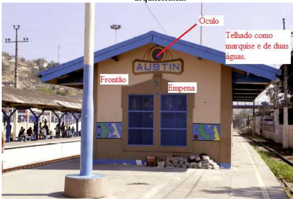
Figura 20: Prédio antigo da Estação de Austin com análise de suas especificidades arquitetônicas
