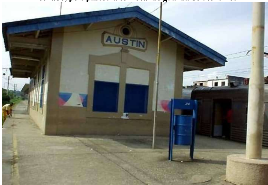
Figura 3: Prédio antigo, após algumas reformas estéticas e que vive fechado, pois passou a ser local de guarda de utensílios
