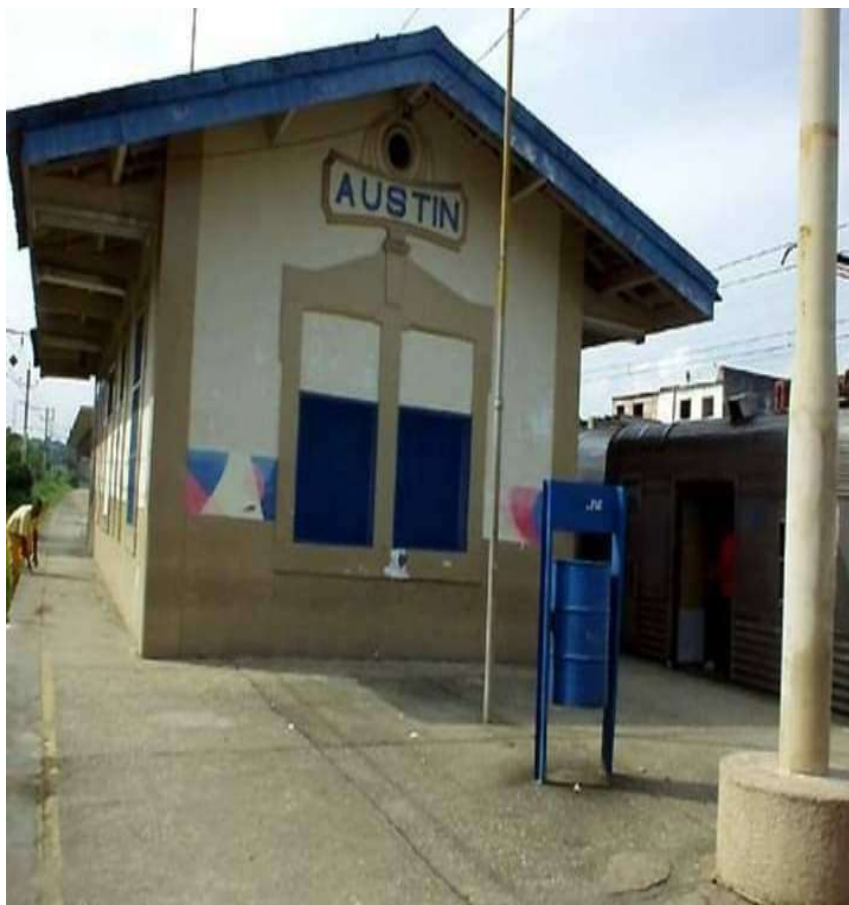
Figura 17: Imagem do Prédio mais recente da Estação de Austin
