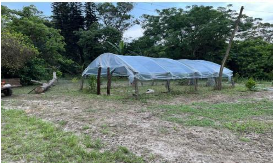
Figura 6. Estrutura existente de estufa 1 antes de limpar (primeira foto). Preparando a estrutura de estufa 1 antes de pôr o filme plástico como teto (segunda foto). Estufa 1 com o filme plástico como teto. Todas as fotos na propriedade Chácara Koscrevic.
