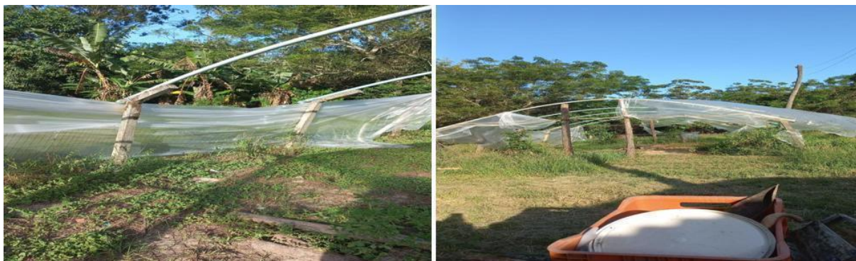
Figura 7. Estufa 1 com teto e parede rasgados.
