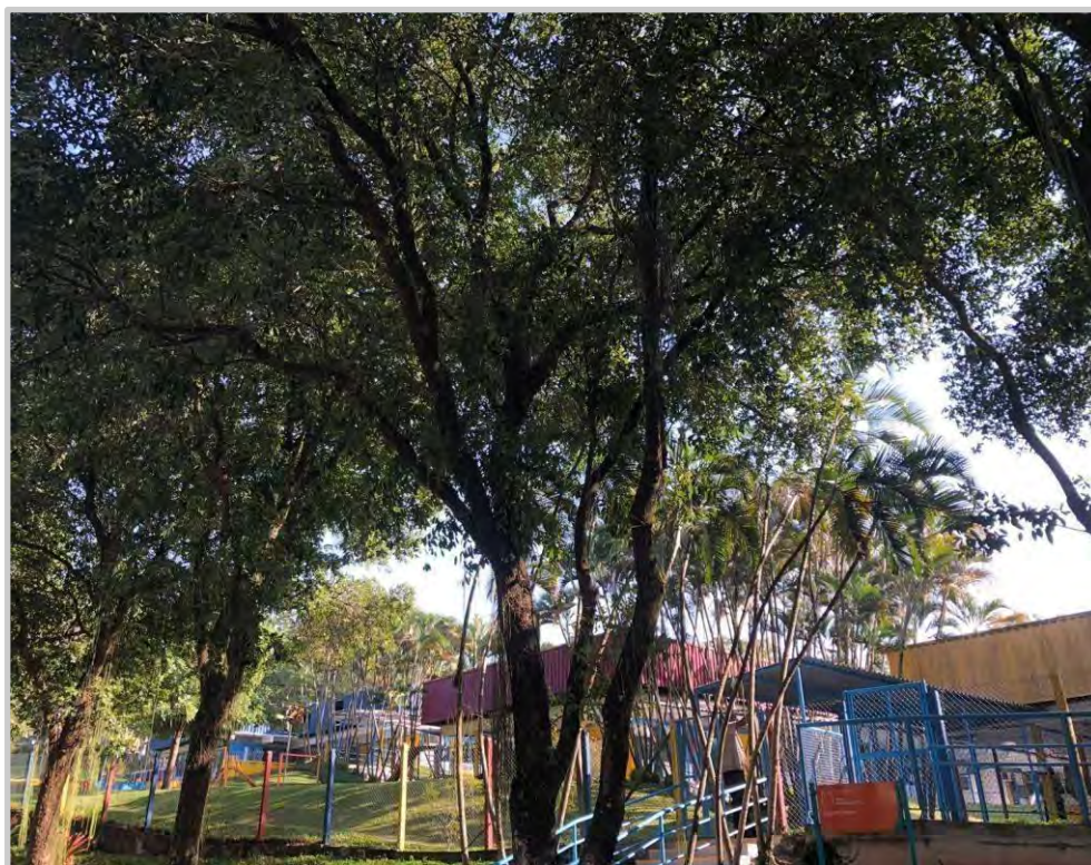
Figura 5 - Fachada da Creche
