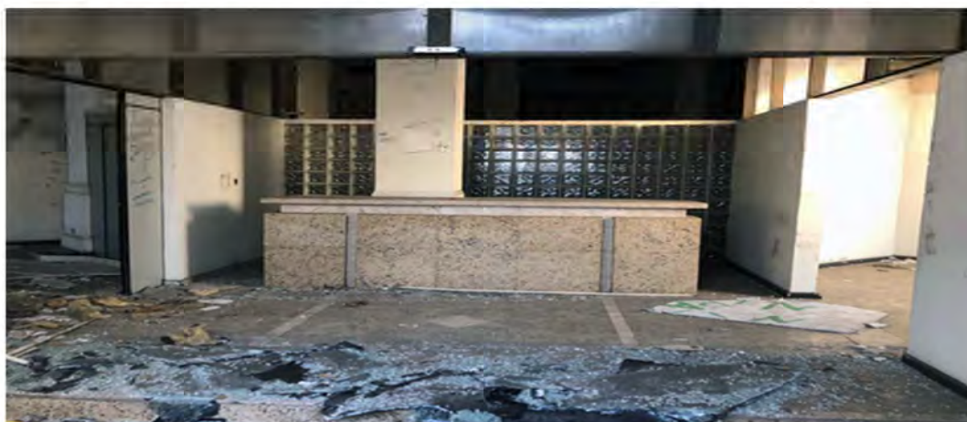
Imagem 13 – Foto do interior do prédio nº3 da Avenida Jansen de Melo de Niterói (2018)
