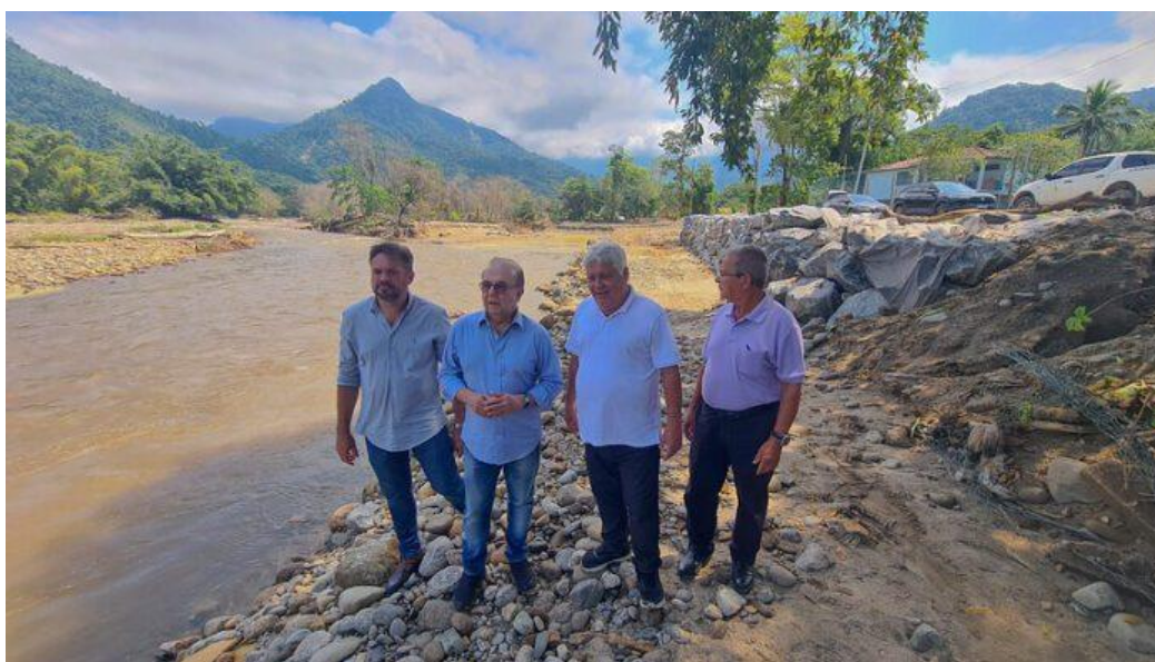
Figura 3 – Prefeito e secretários de Angra vistoriam obras no Rio Bracuí.
