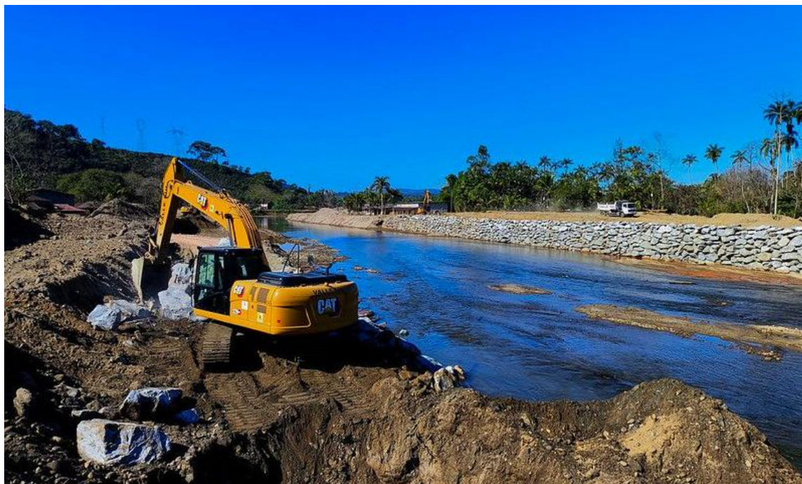
Figura 1 – Obras de enrocamento no Rio Bracuí
