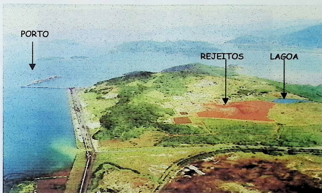
Figura 13. Porto de Sepetiba, Lagoa de decantação e pilha de rejeitos da Ingá.
