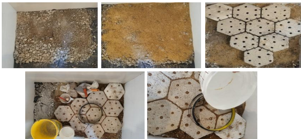
Figura 27 – Preparação das camadas para assentamento, instalação dos pavers e ensaio de permeabilidade.
