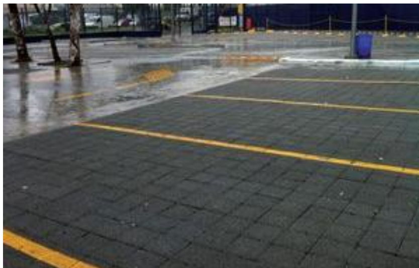
Figura 7 - Revestimento de pavimento constituído de placas de concreto permeável.
