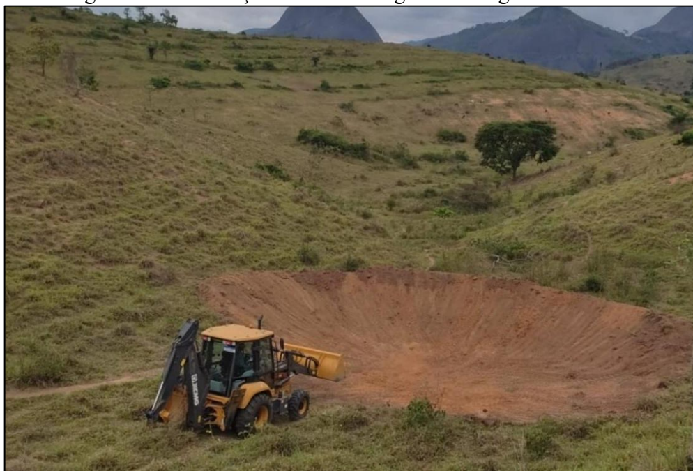
Figura 16 - Construção de uma barraginha em Águia Branca-ES
