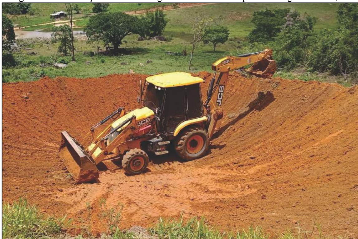
Figura 01 - Construção de uma barraginha em formato de prato em Águia Branca, ES
