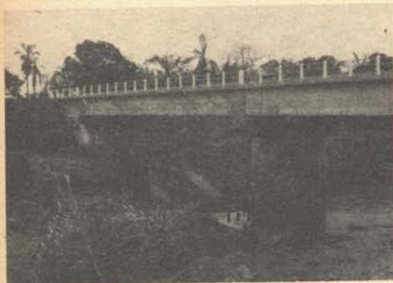
La obra recién terminada, sobre los restos de la vieja estructura destruida
