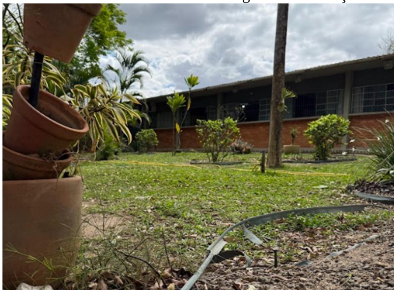
Figura 5 - Fachada do CEIER - Centro Estadual Integrado de Educação Rural de Vila Pavão
