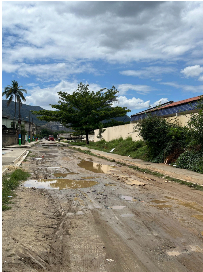
Figura 43 - Observação do meio
