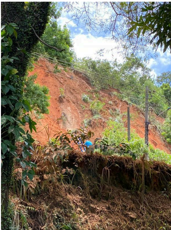
Figura 41 - Observação do meio
