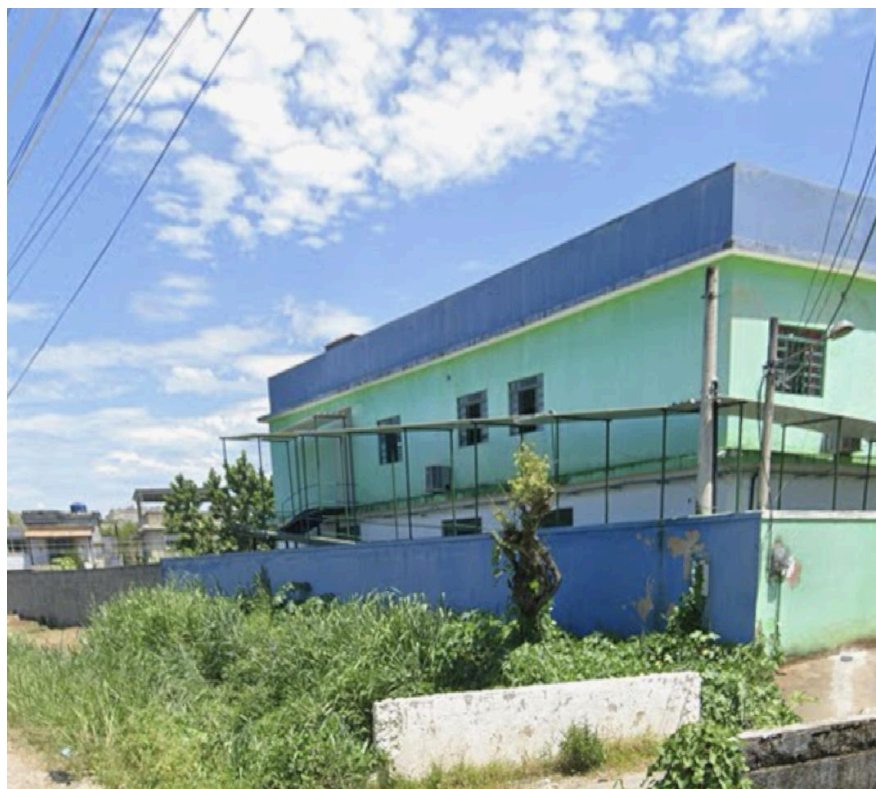
Figura 16- Lateral da Escola Municipal Frei Maurício Viann
