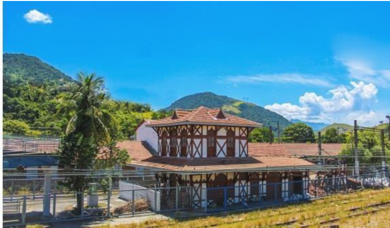
Figura 05 - Casarão da Estação Ferroviária em Japeri- RJ
