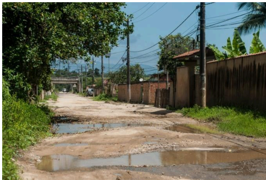
Figura 13 - Alagamento em rua no município de Japeri-RJ
