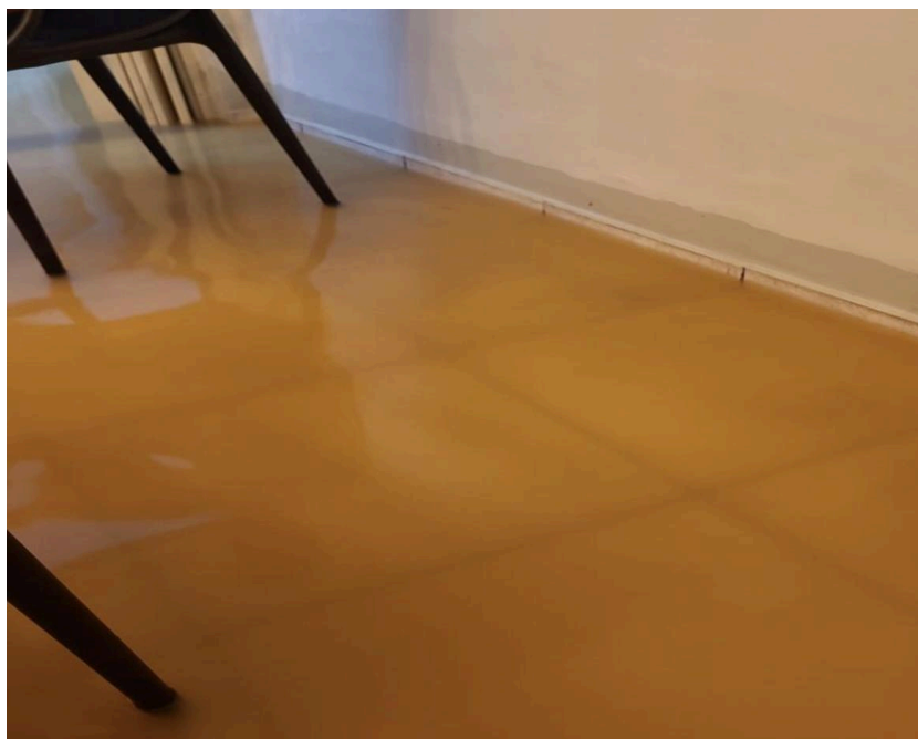
Figura 09 - Residência inundada em Japeri-RJ
