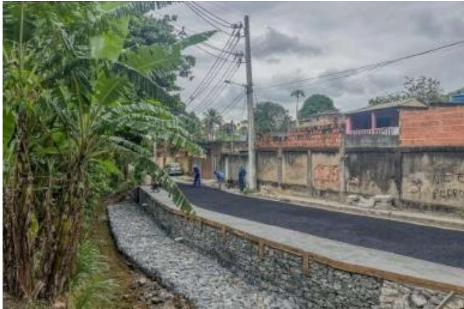
Figura 14 - Construção do muro de contenção em ruas afetadas pela chuva em Japeri-RJ
