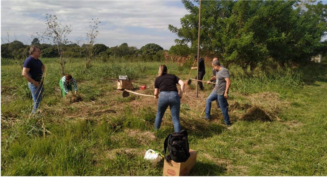
Figura 35. Retirada da vegetação do local para instalação da sonda multissegmentada. Fonte: Acervo Fotográfico do Autor.
