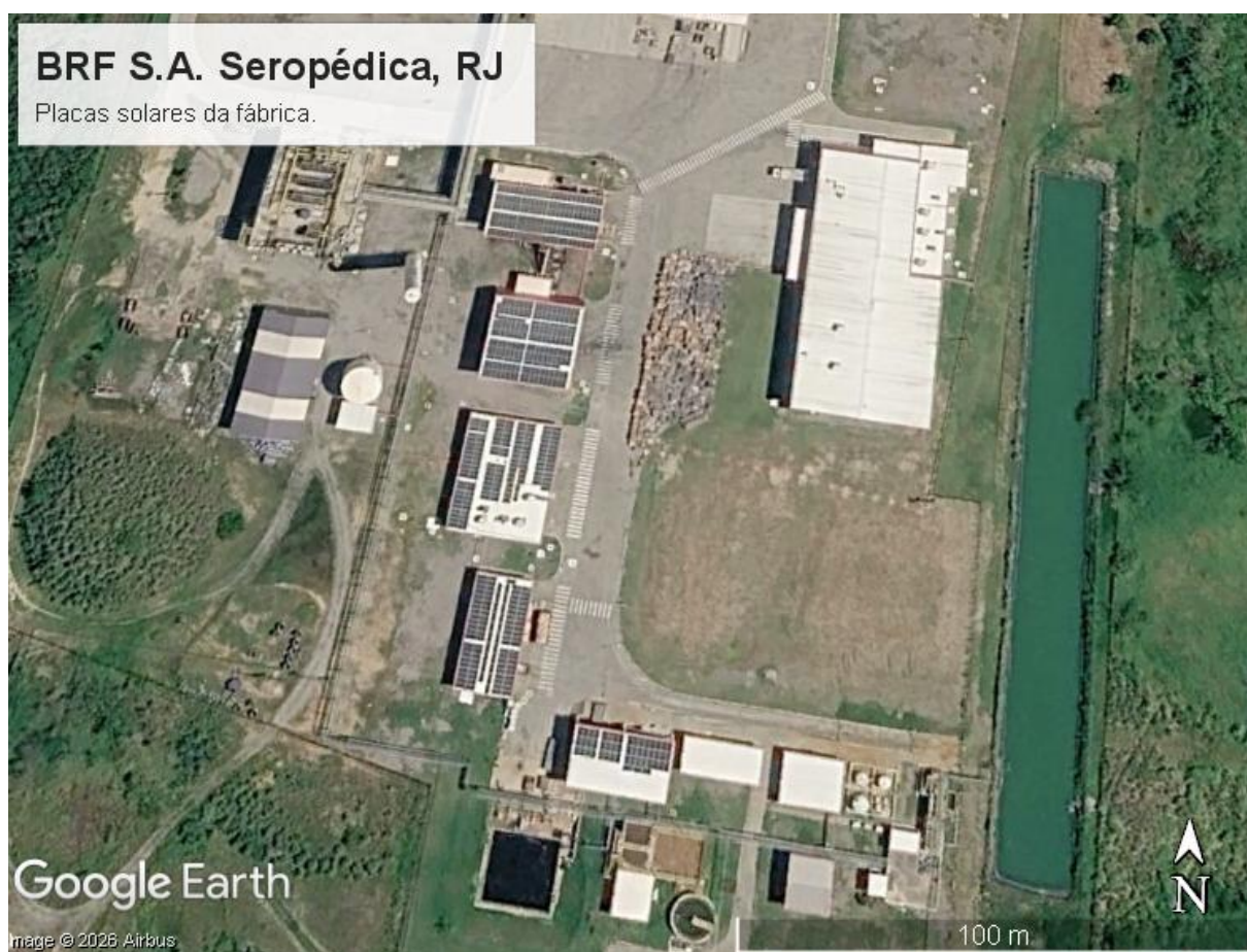
Figura 8 – Placas solares instaladas na BRF S.A., unidade Seropédica
