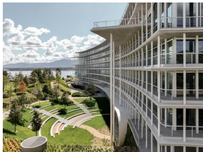
Figura 3. Edifício Sede da Lombard Odier, Suíça.
