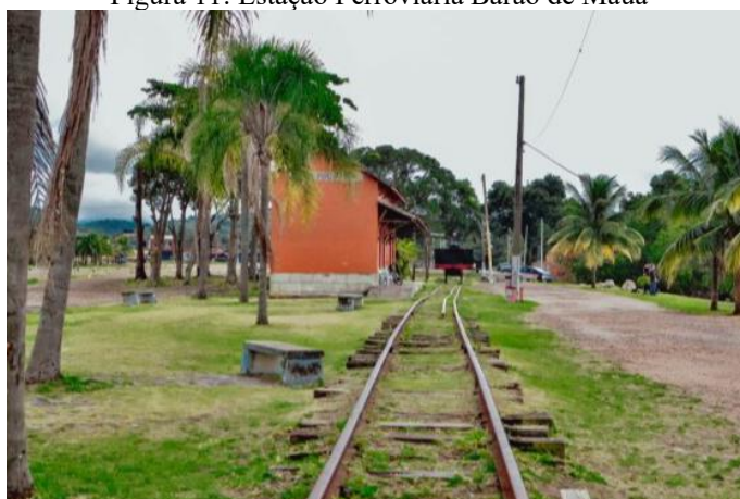
Figura 11: Estação Ferroviária Barão de Mauá
