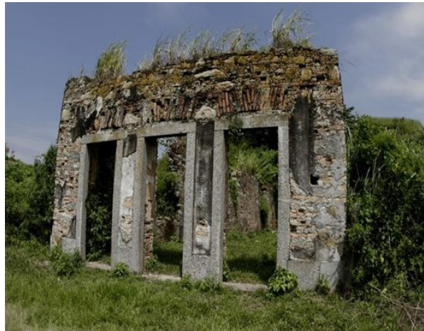
Figura 20: Casa das Três Portas
