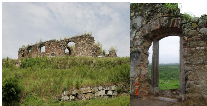
Figura 19: Ruínas da Igreja e Porto Estrela, em 2005, detalhe do arco cruzeiro, ano do tombamento.
