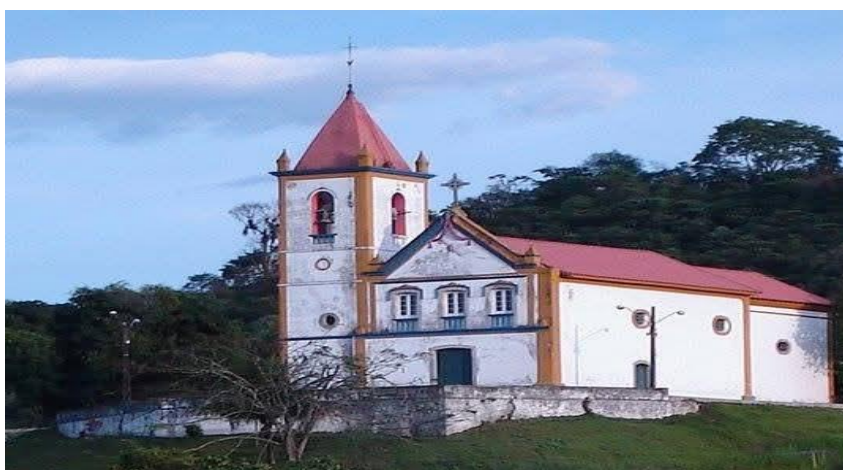
Figura 16: Fachada principal da Igreja de São Nicolau, século XVIII
