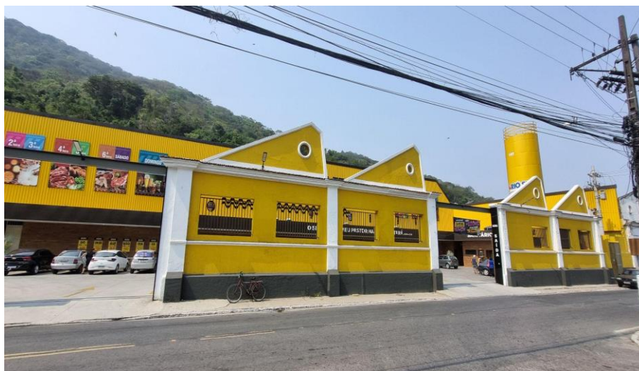
Figura 4 - Mercado Rio Sul instalado em um dos galpões da antiga Fábrica Santo Aleixo (2024)
