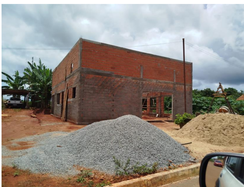
Figura 5 – Edificação do futuro prédio do centro comunitário
